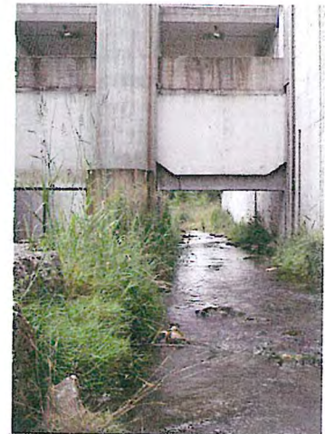
Die Selke wird unter beiden Dämmen ungehindert hindurchfließen. Der Fischauf- und -abstieg ist gewährleistet.
