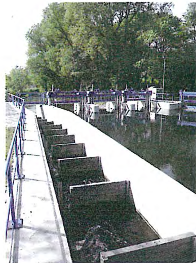
Das neue Selkewehr Gatersleben mit Fischtreppe verbindet Hochwasserschutz und Ökologie.
