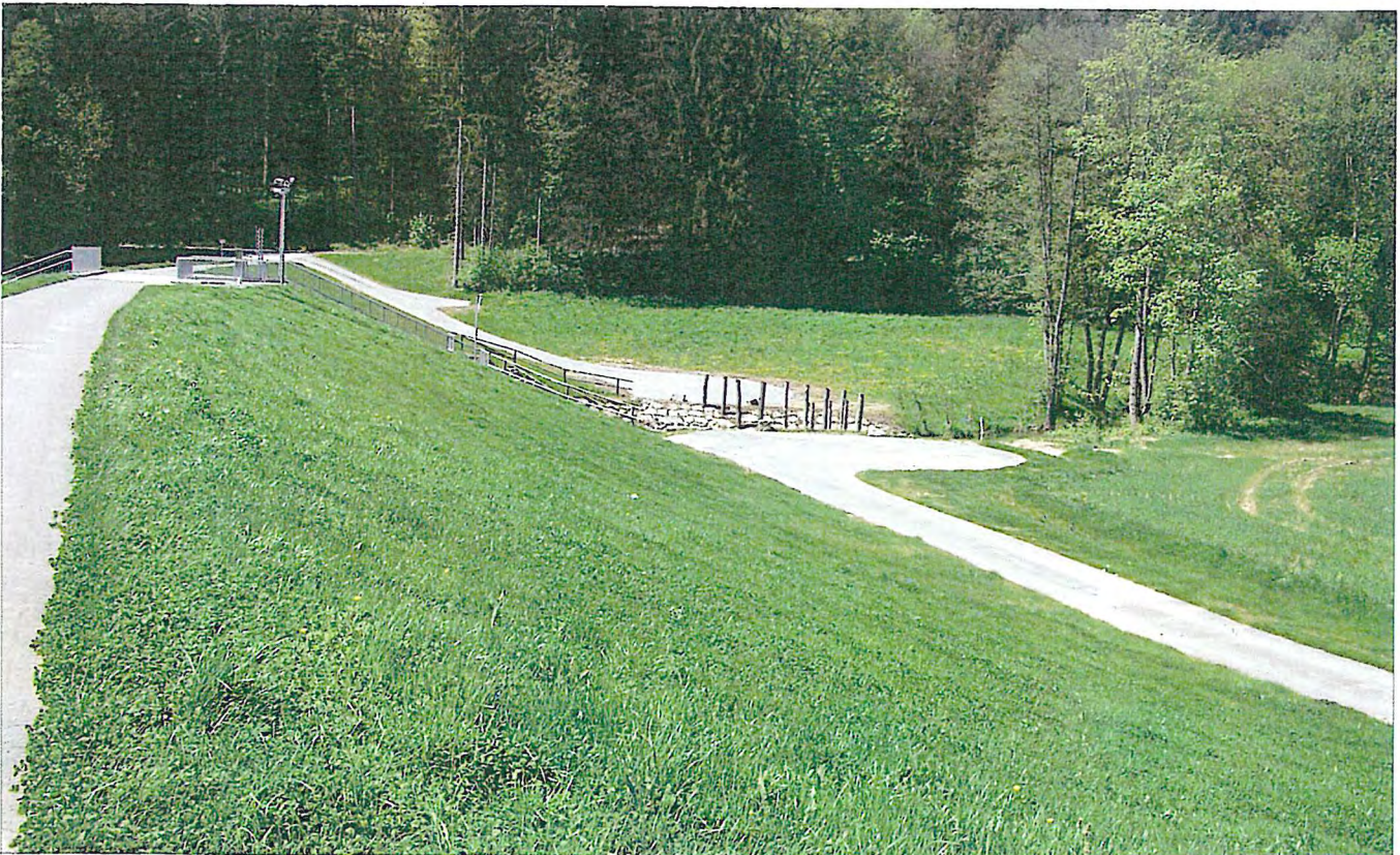
Begrünter Erdwall in Adelsheim, Neckar-Odenwald-Kreis. Der erlenbestandene Ufersaum reicht bis zum Dammfuß. Die Rückhaltebecken im Harz sehen nach Fertigstellung vergleichbar aus.
